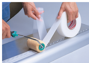
③ 粘着剤面から保護フィルムを剥がしながら、クッション性のあるローラーで軽く圧着します。
